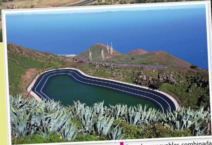
Energías renovables combinadas en la central de Gorona, El Hierro.
